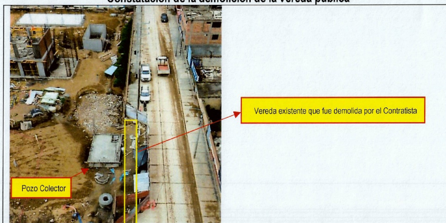
Fotografía n.º 25 Constatación de la demolición de la vereda pública
