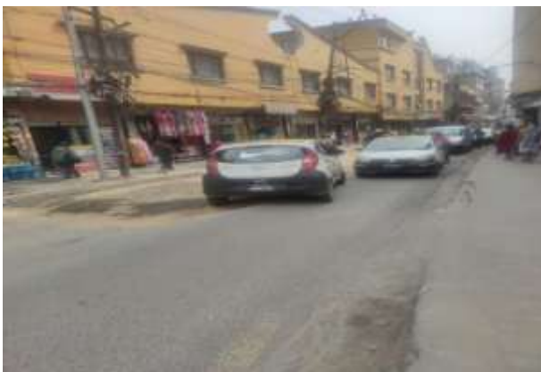
खानेपानीको पाइप फुटेर बिग्रिएका कारण थापाथलीमा एकतर्फी रूपमा सञ्चालनमा रहेको सडक
