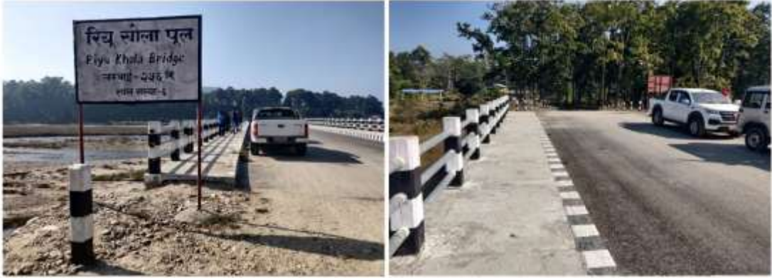
राष्ट्रिय निकुञ्जबाट सडक निर्माणको अनुमति प्राप्त नहुँदा वीरगंज योजना कार्यालयबाट निर्माण सम्पन्न भएको तर प्रस्तावित रेखाङ्कनमा नपर्ने रिग्यु खोला पुल
