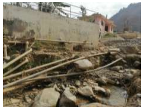
मेन पाइपलाइनमा बाढीबाट भएको क्षति
